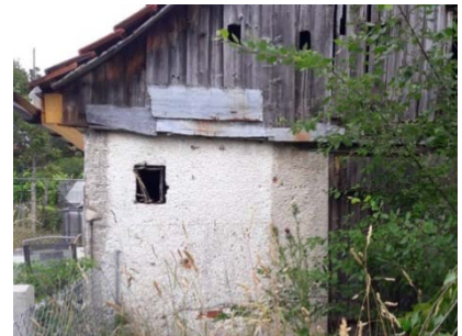
Gartenhaus Schäden an Dach, Putz- und Holzfassade sowie Tragwerk
