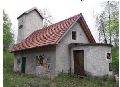
Gartenhaus Schäden an Dach, Putz- und Holzfassade sowie Tragwerk
