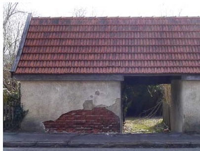
Gartenhaus und Gartenzugang Schäden an Mauerwerk und Putz
